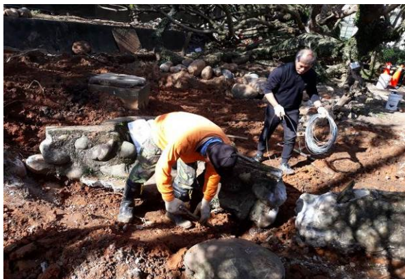
說明：人工整坡整河階水道
