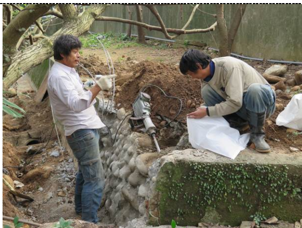
說明：人工整坡整河階水道
