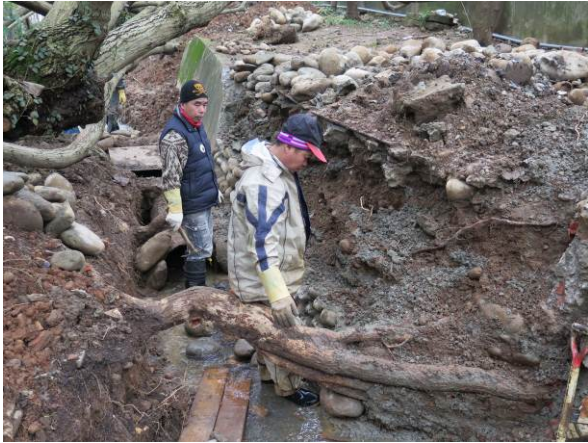
說明：舊有邊坡牆面拆除
