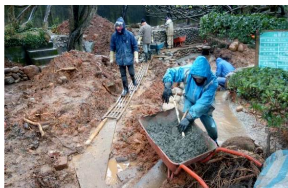
說明：河道整修及防水工程
