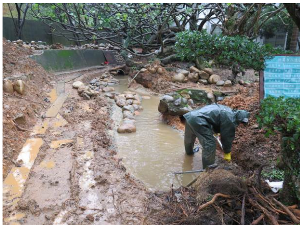
說明：沉砂池設置
